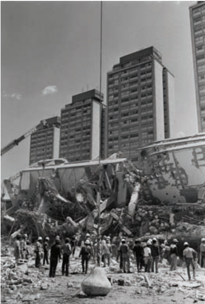
Terremoto de septiembre de 1985 (Tlatelolco, Ciudad de México).
